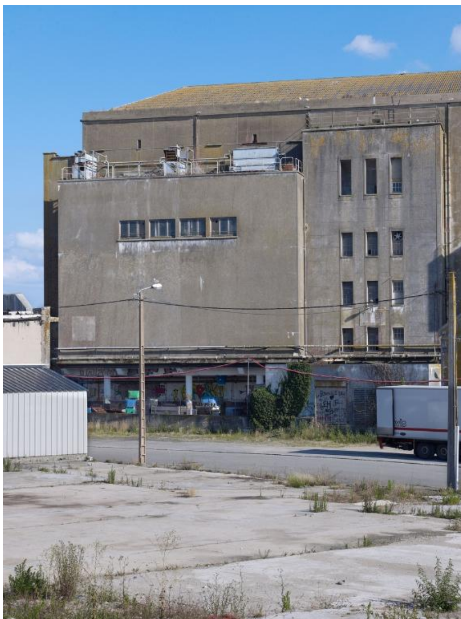
Frigorifique de Keroman, vue générale
