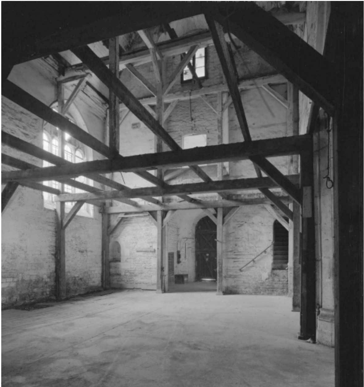
Bras sud du transept
