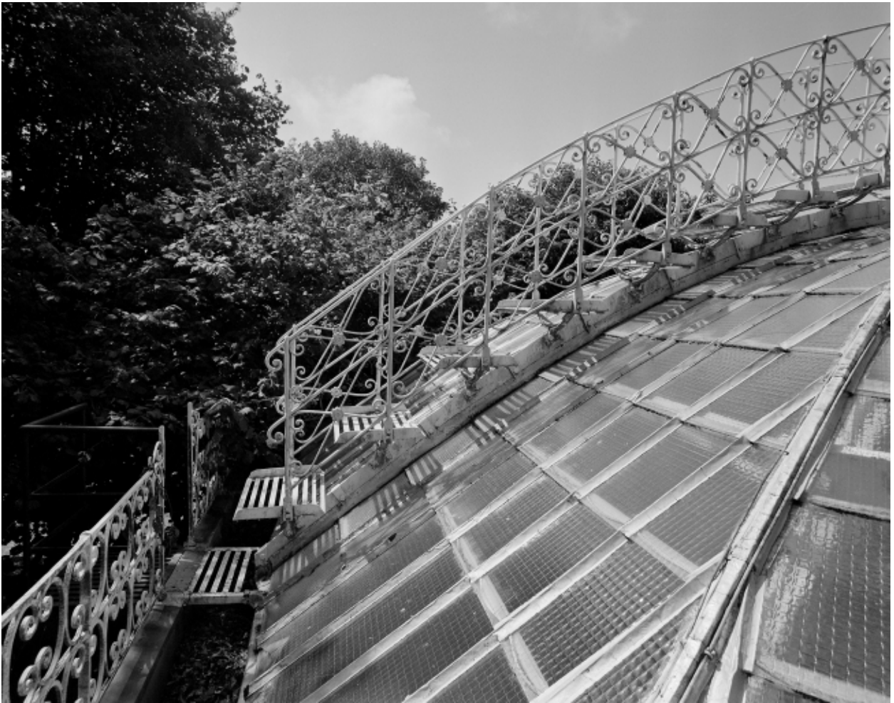
Détail de ferronnerie, début rampe d'escalier (parcelles n°9 et n°10, section A 1982).
