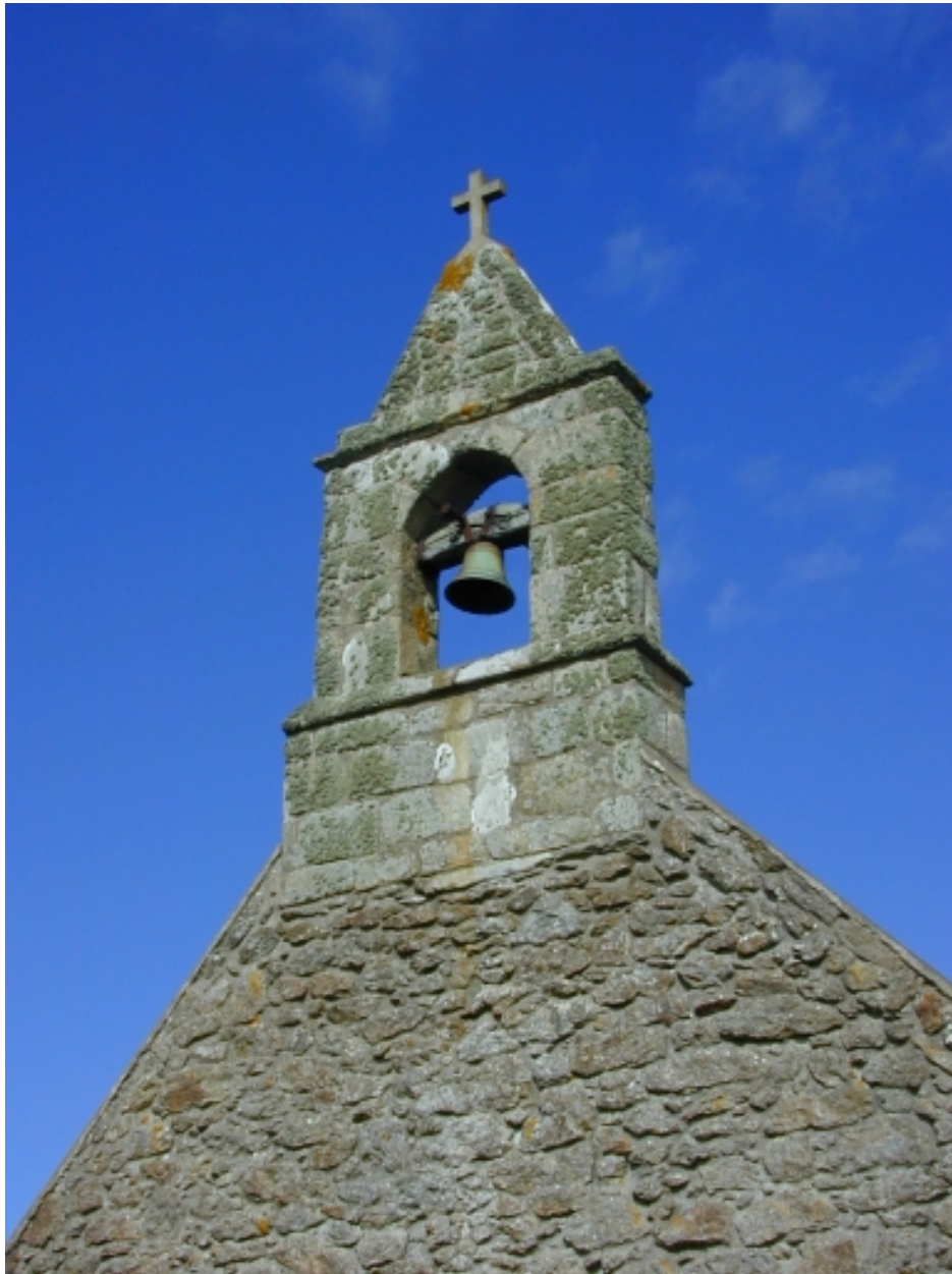
Détail : le clocher-mur vu de l'ouest
