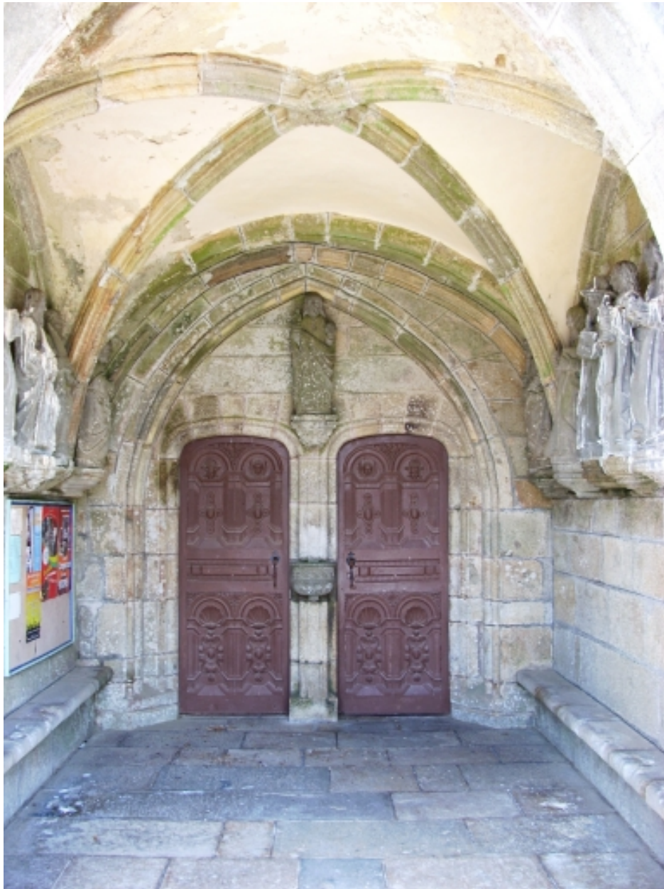
Plouneventer, église paroissiale Saint-Néventer : porche sud, intérieur, détail
