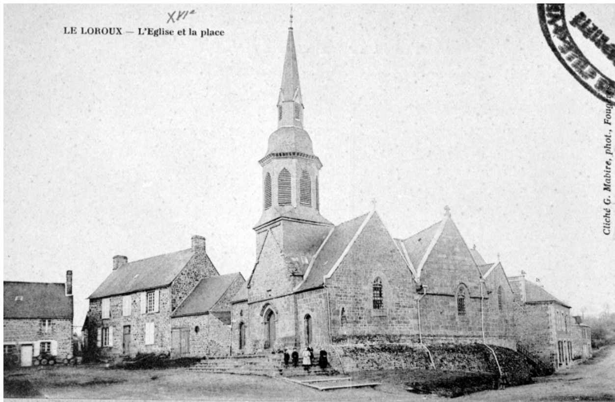
Elévation Sud-Ouest : vue générale (Carte postale ancienne, AD35 : 6Fi)
