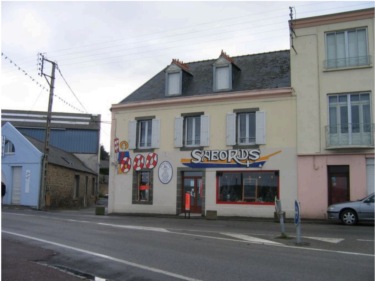
Vue générale de l'ancienne conserverie Béziers depuis la rue
