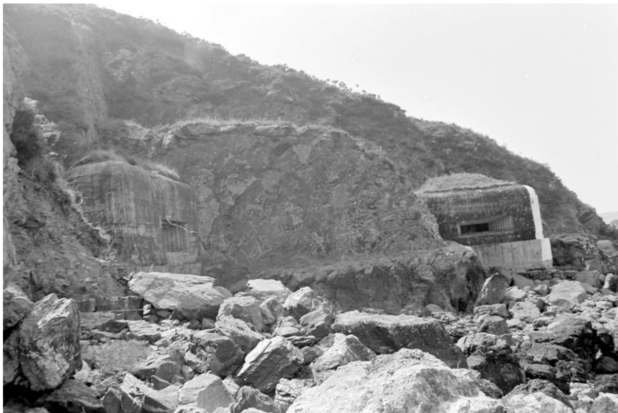
Vue générale des deux embrasures (état en 1969)
