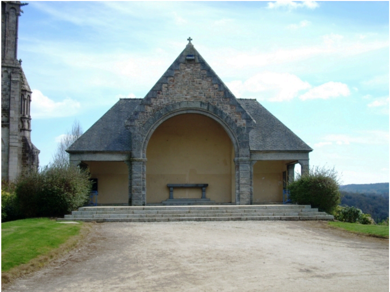
Châteauneuf-du-Faou, chapelle Notre-Dame-des-Portes : chapelle extérieure, élévation ouest
