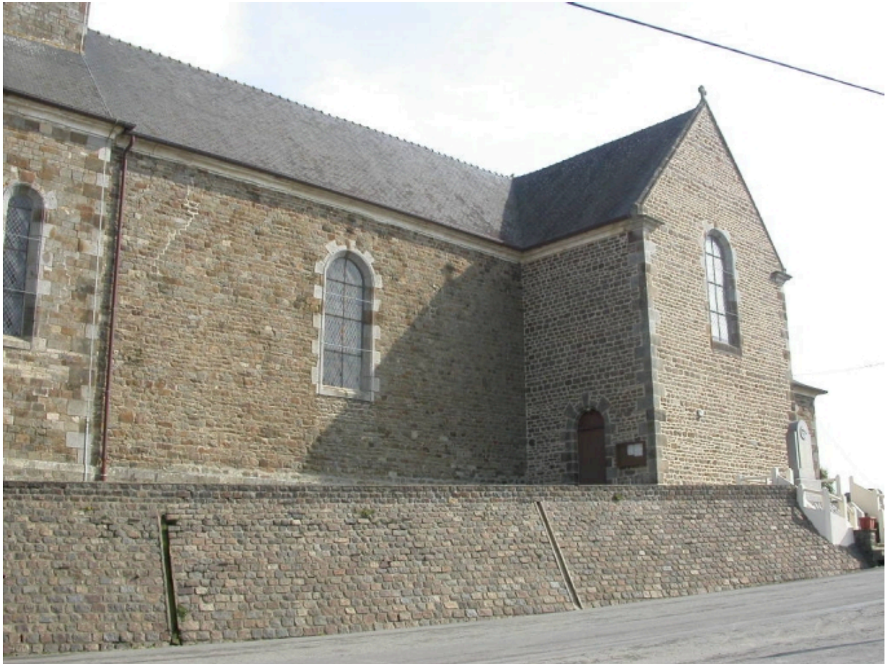
Façade sud de l'église
