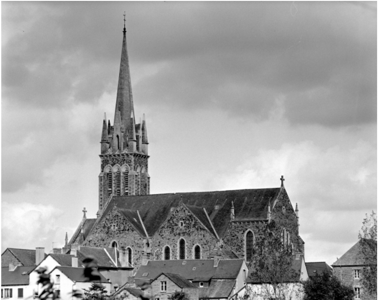
Elévation Sud : vue générale
