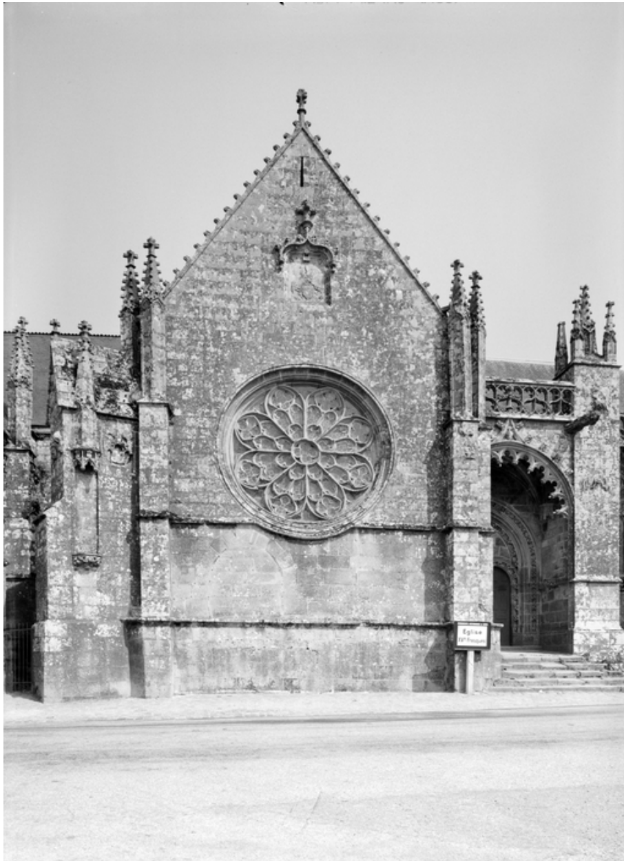
Pignon du bras sud du transept.
