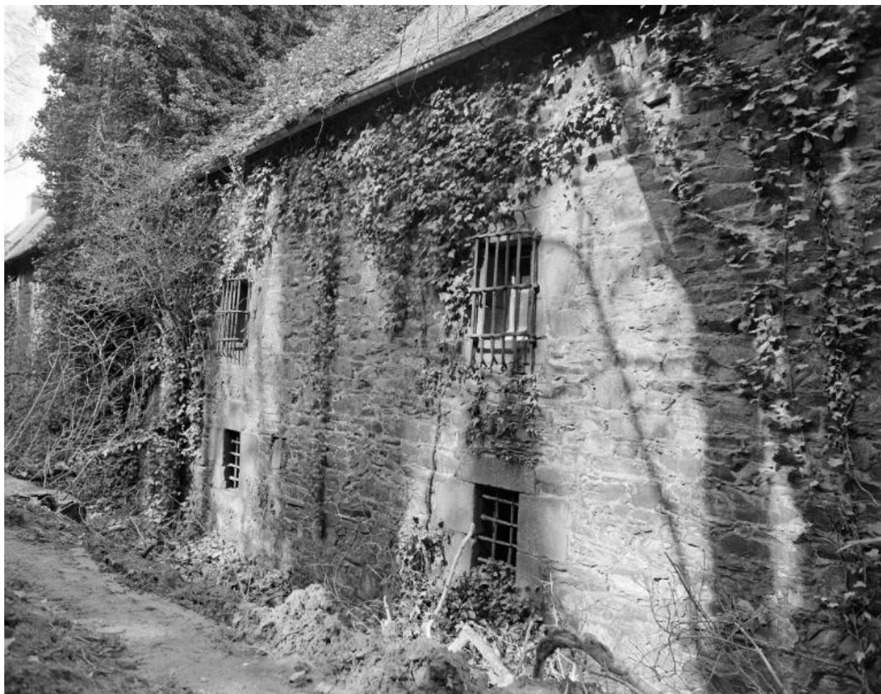
Façade postérieure : vue générale.
