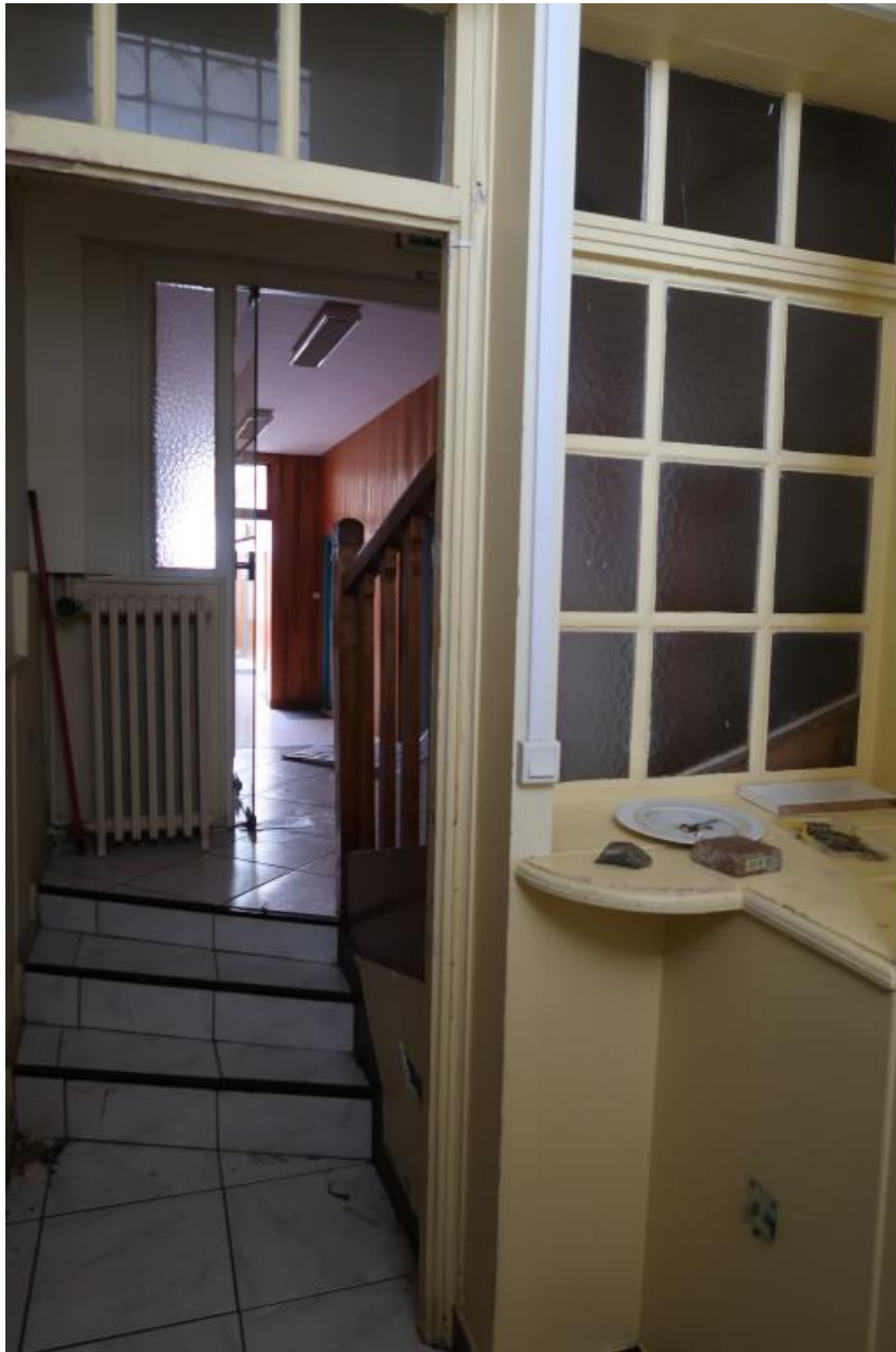
Intérieur, rez-de-chaussée, hall, cage d'escalier
