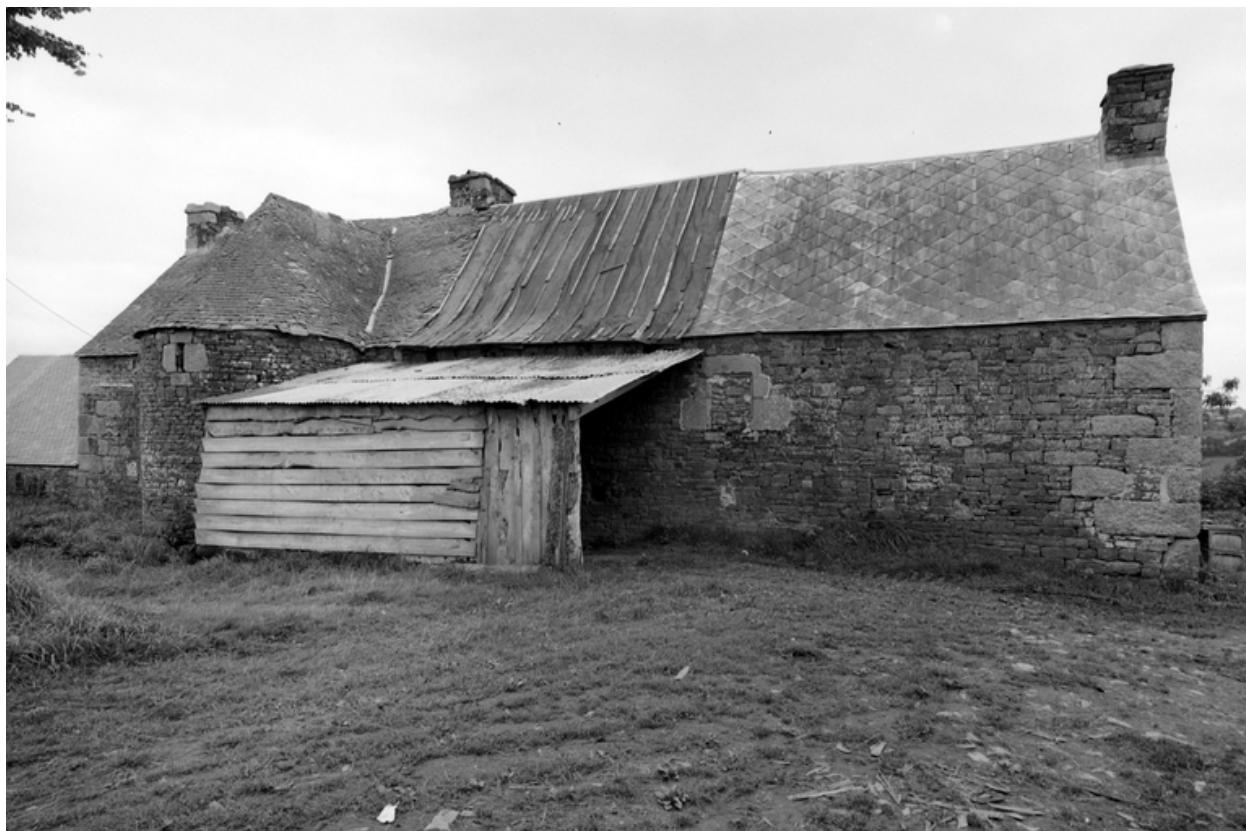
Vue de la façade nord
