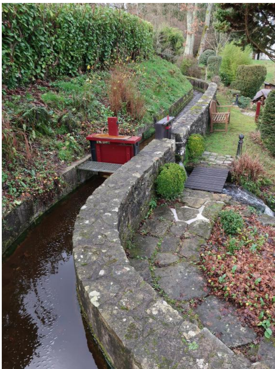
Loguivy-Plougras, le bourg : Moulin à eau de Traou an Dour, rigole du canal d'amenée (vanne permettant de réguler ou fermer l'alimentation en eau)
