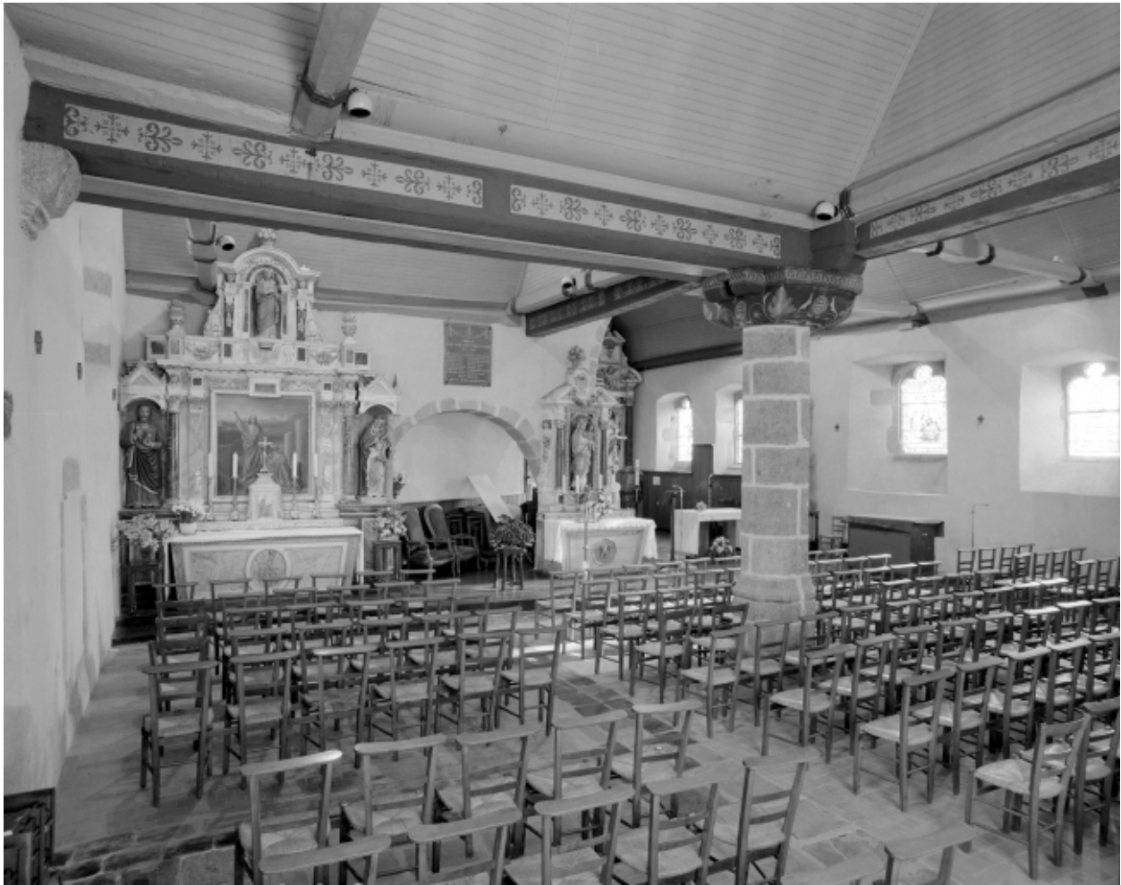
Intérieur, bras Nord du transept : vue générale.
