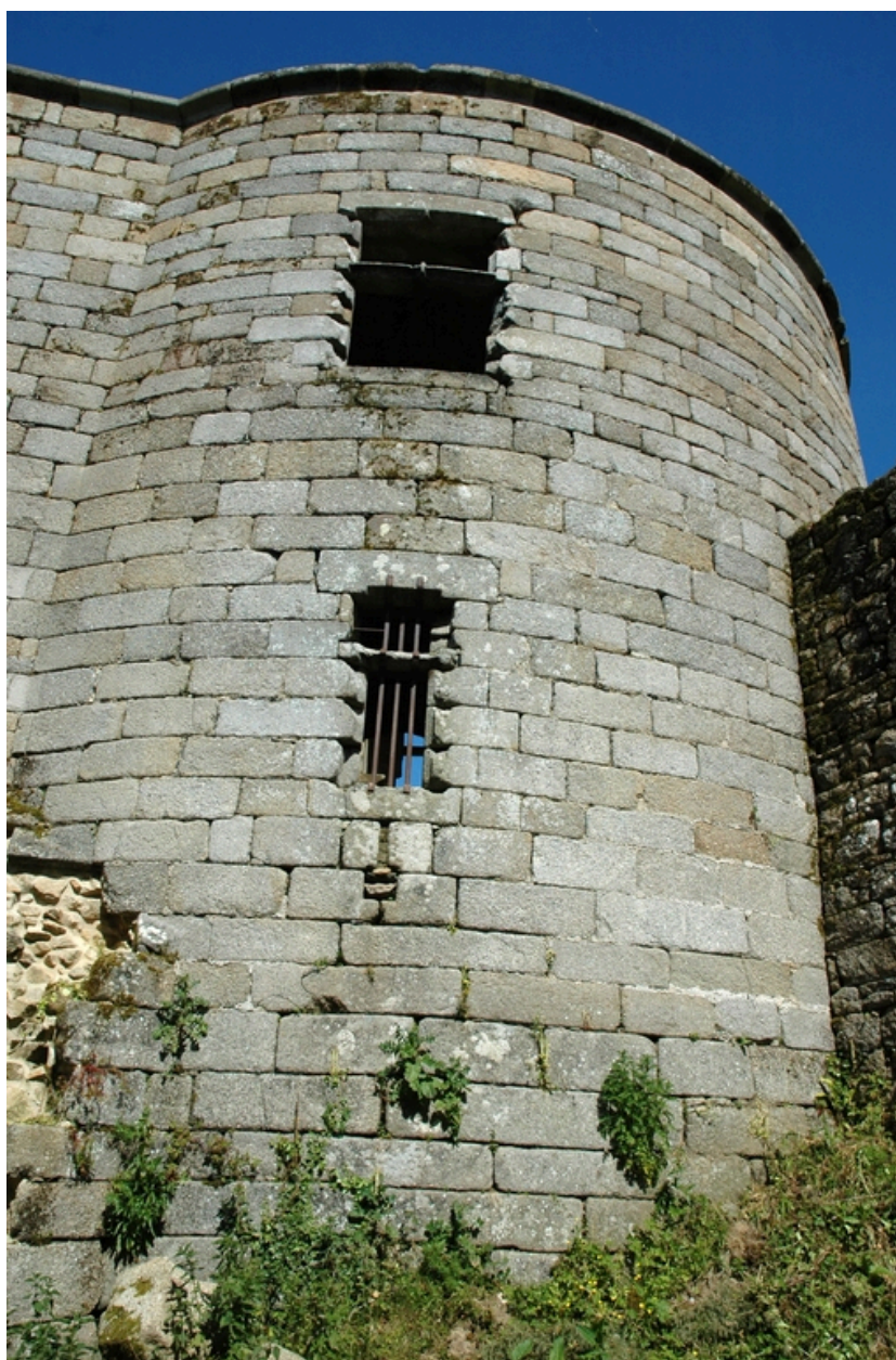
Vue du front ouest : tour en contre-plongée
