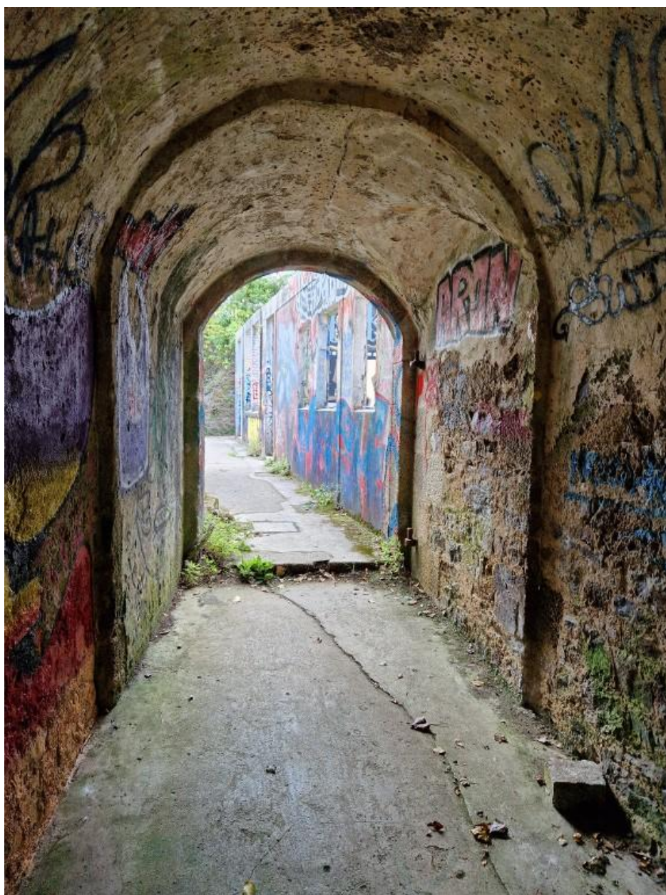
Vue du passage voûté de la poterne (état en 2024). Deux portes en fermaient l'accès
