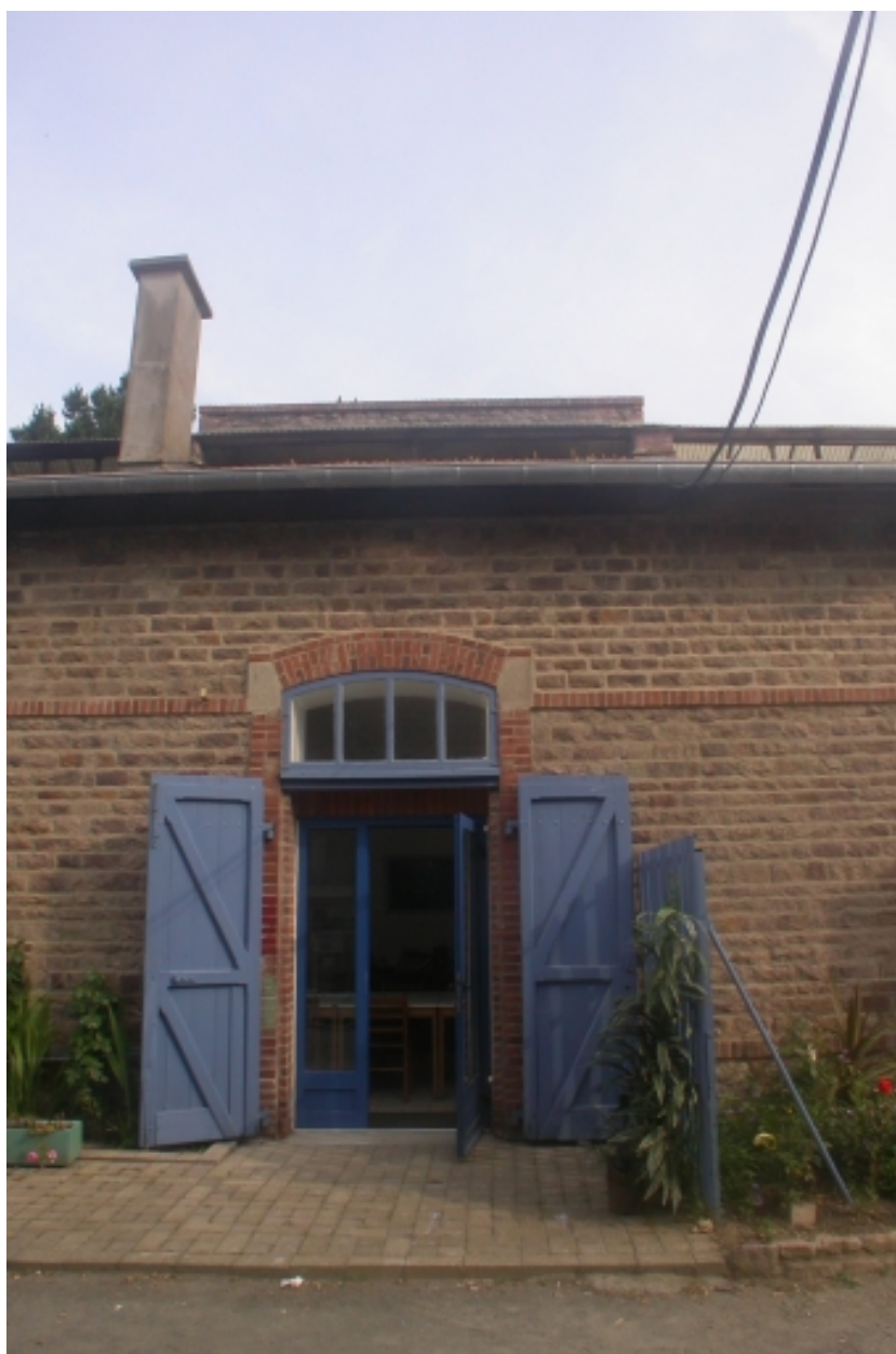
Détail de la façade postérieure.
