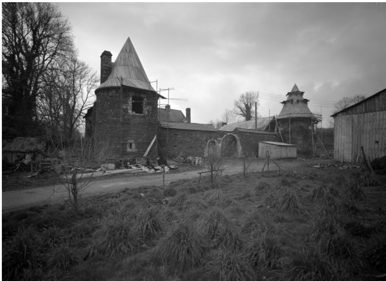
Vue générale avec les tours
