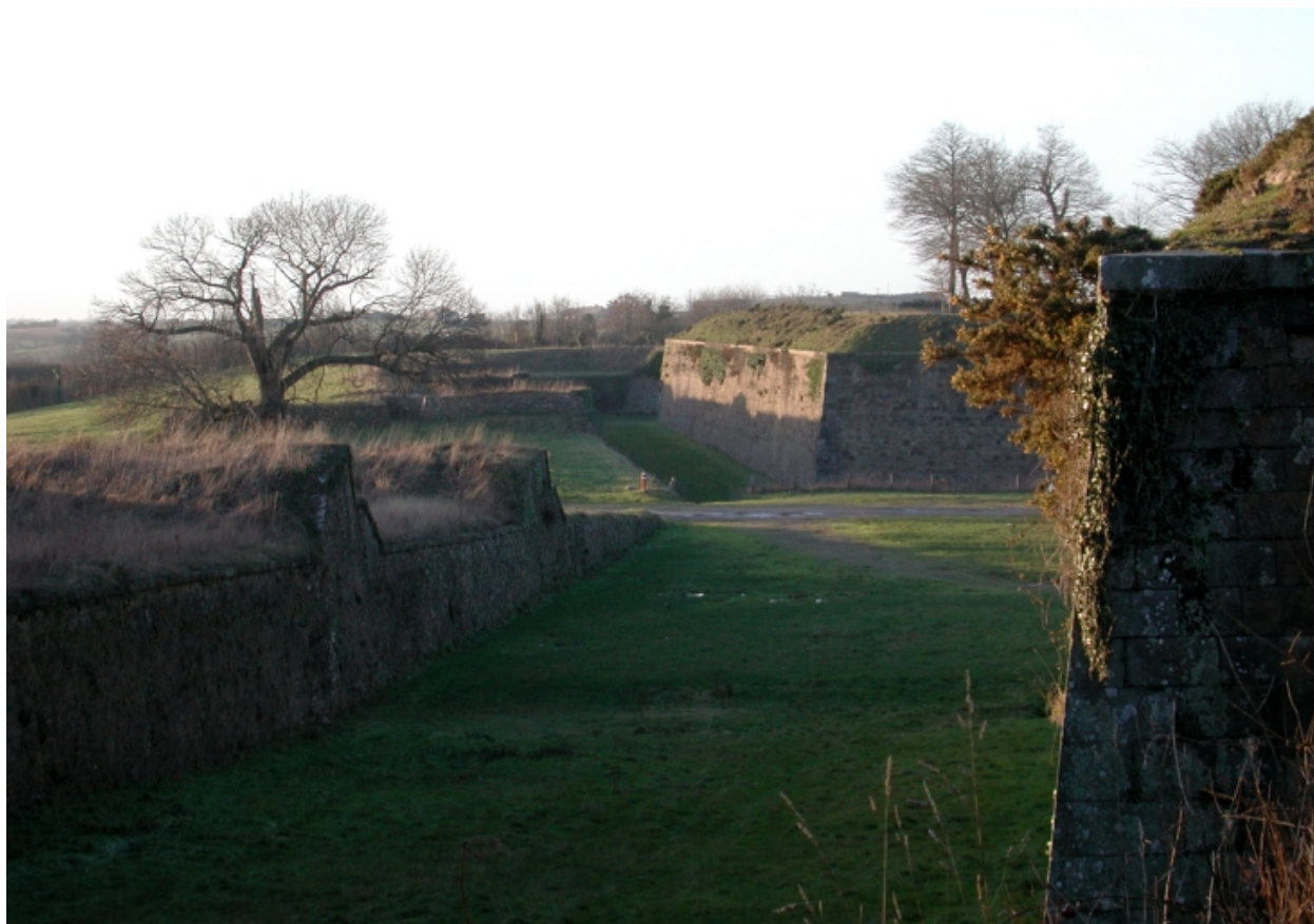
Vue du front sud
