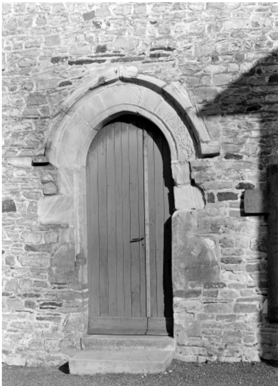
Elévation Sud, porte : vue générale
