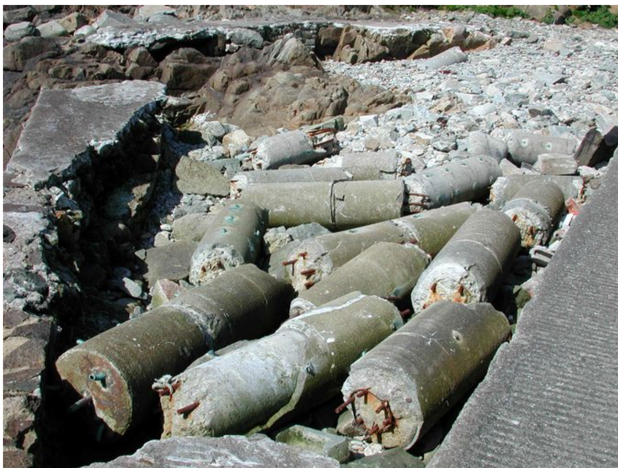
Vue des vestiges de la première cale (état en 2002)
