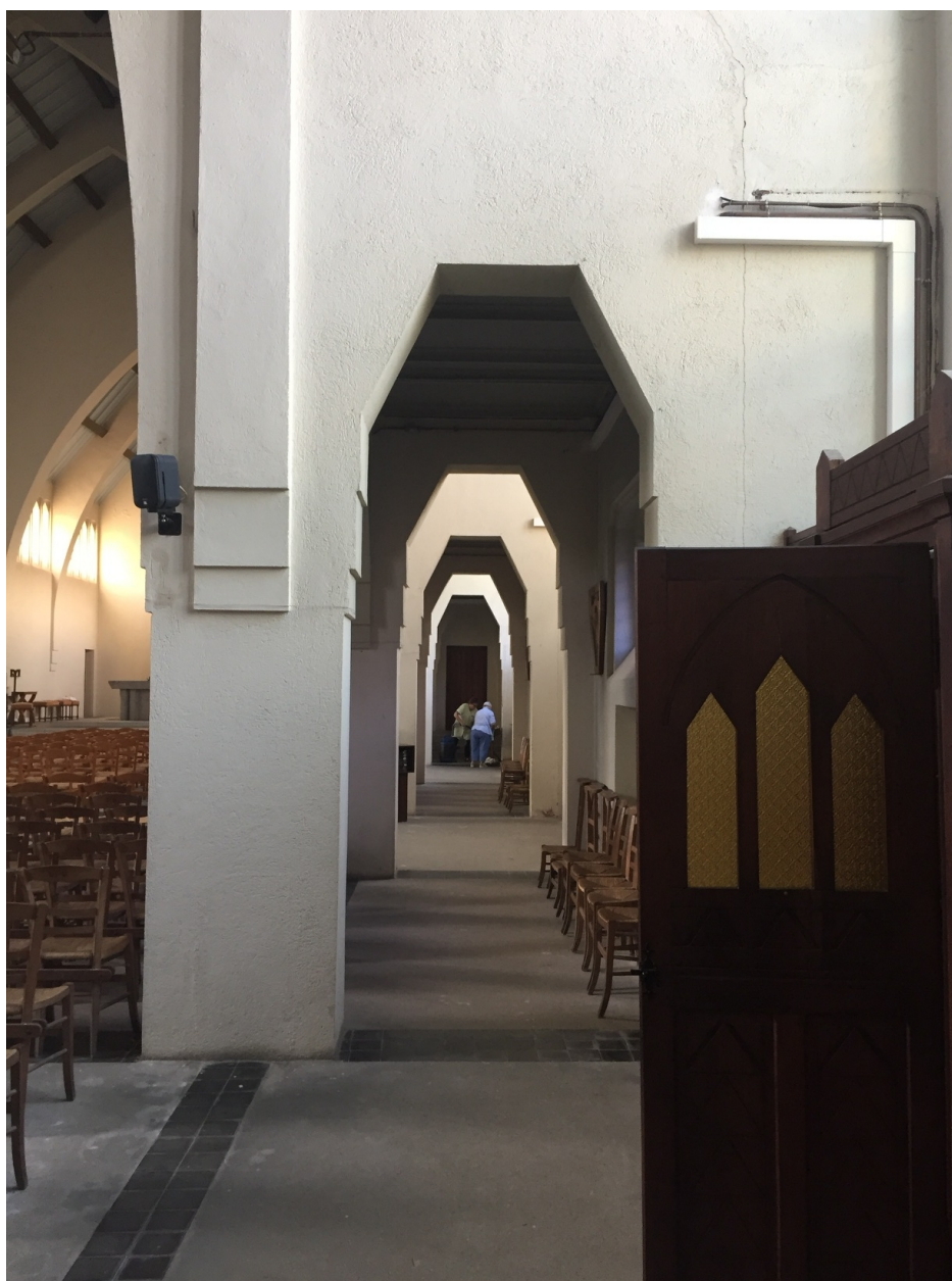
Vue intérieure collatéral avec rangées de colonnes béton recouverte d'un enduit ciment
