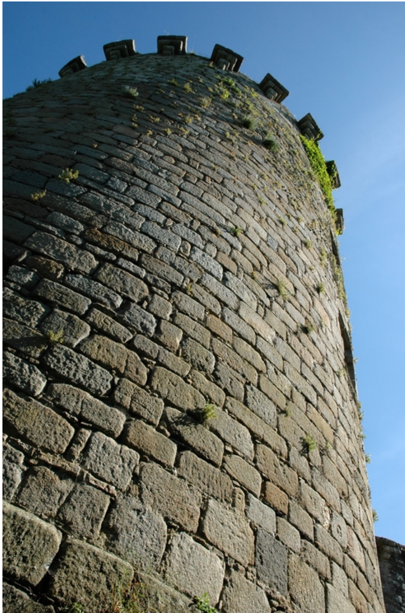
Vue de la tour nord dite dit tour de Rougé : détail de la maçonnerie en pierre de taille
