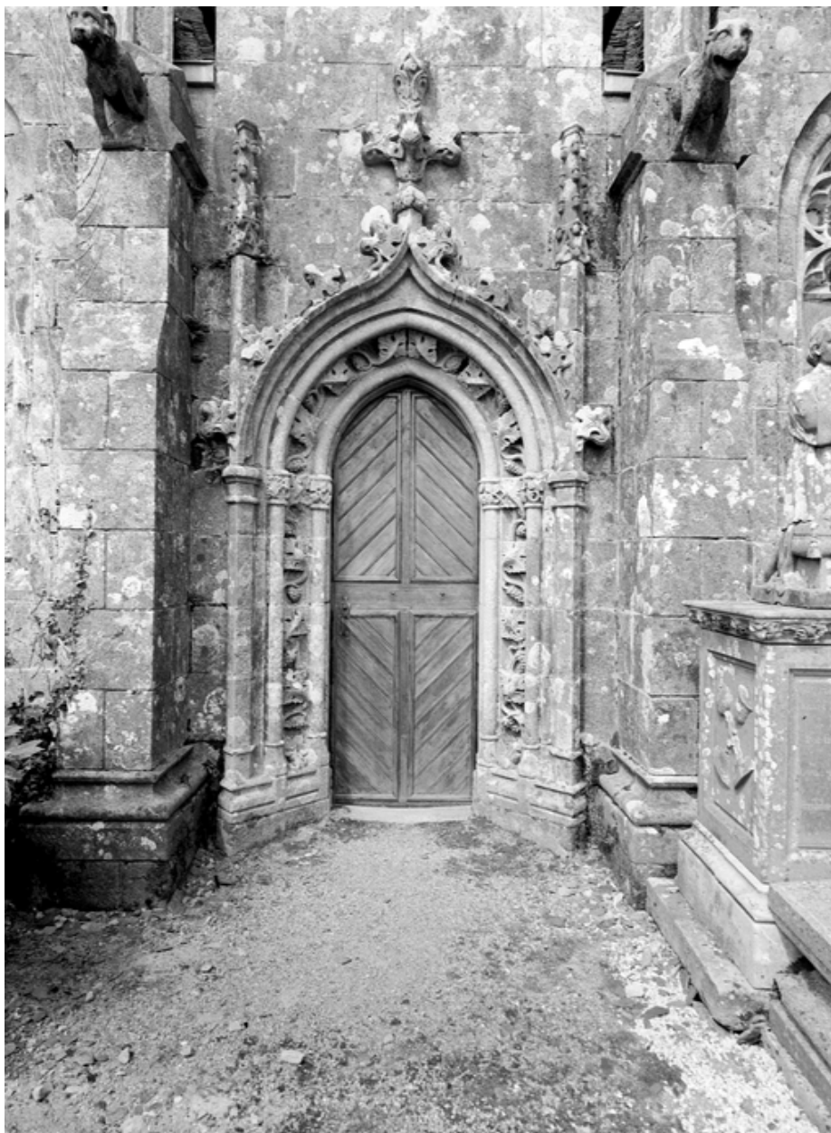
Porte du mur sud (partie ouest)
