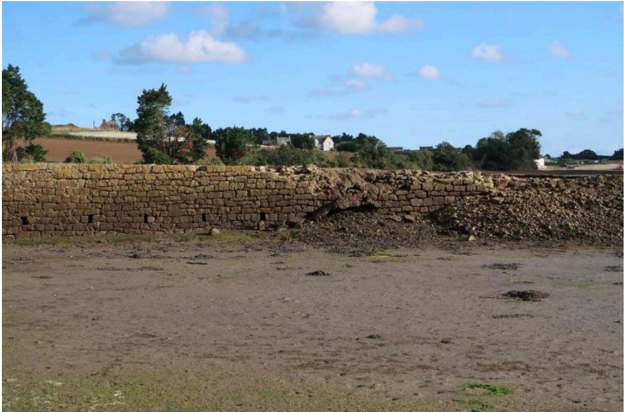
Vue de détail de l'élévation sud : maçonnerie de moellon de granite. Des portions de cale sont fortement dégradées par l'érosion marine
