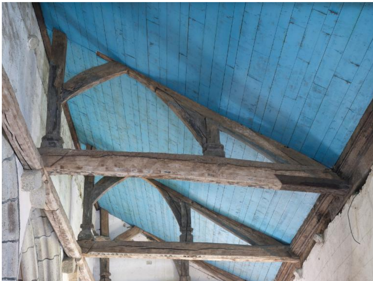
Charpente du bas côté sud vue vers le chevet
