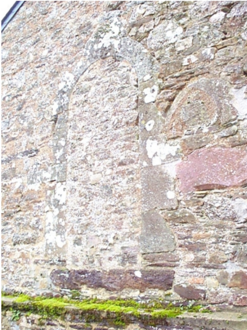
Sacristie nord, porte du 16e siècle en remploi : détail
