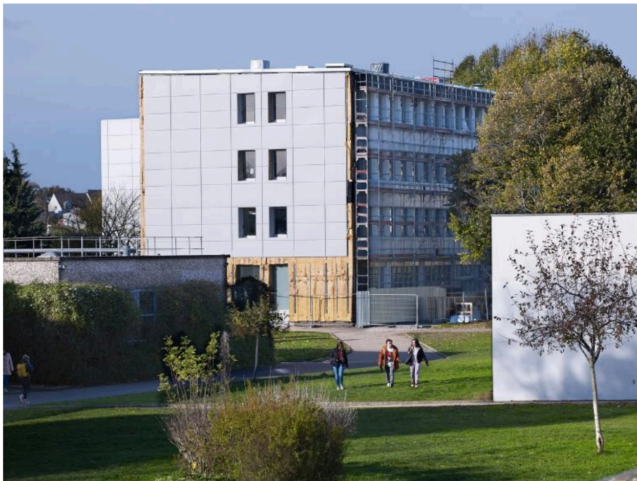
Internat garçons n°4 transformé en "espace langues", en cours de réhabilitation thermique. Pignon sud-est.
