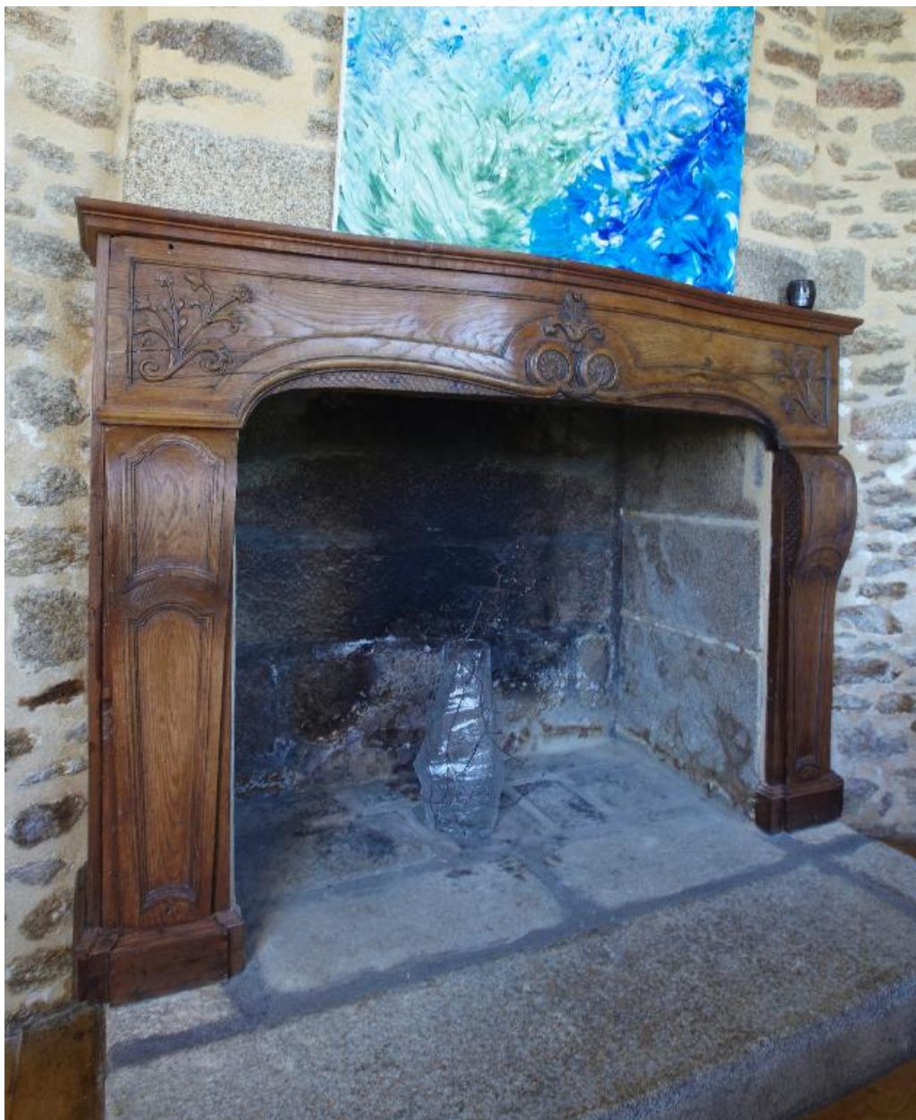
Cheminée située au rez-de-chaussée
