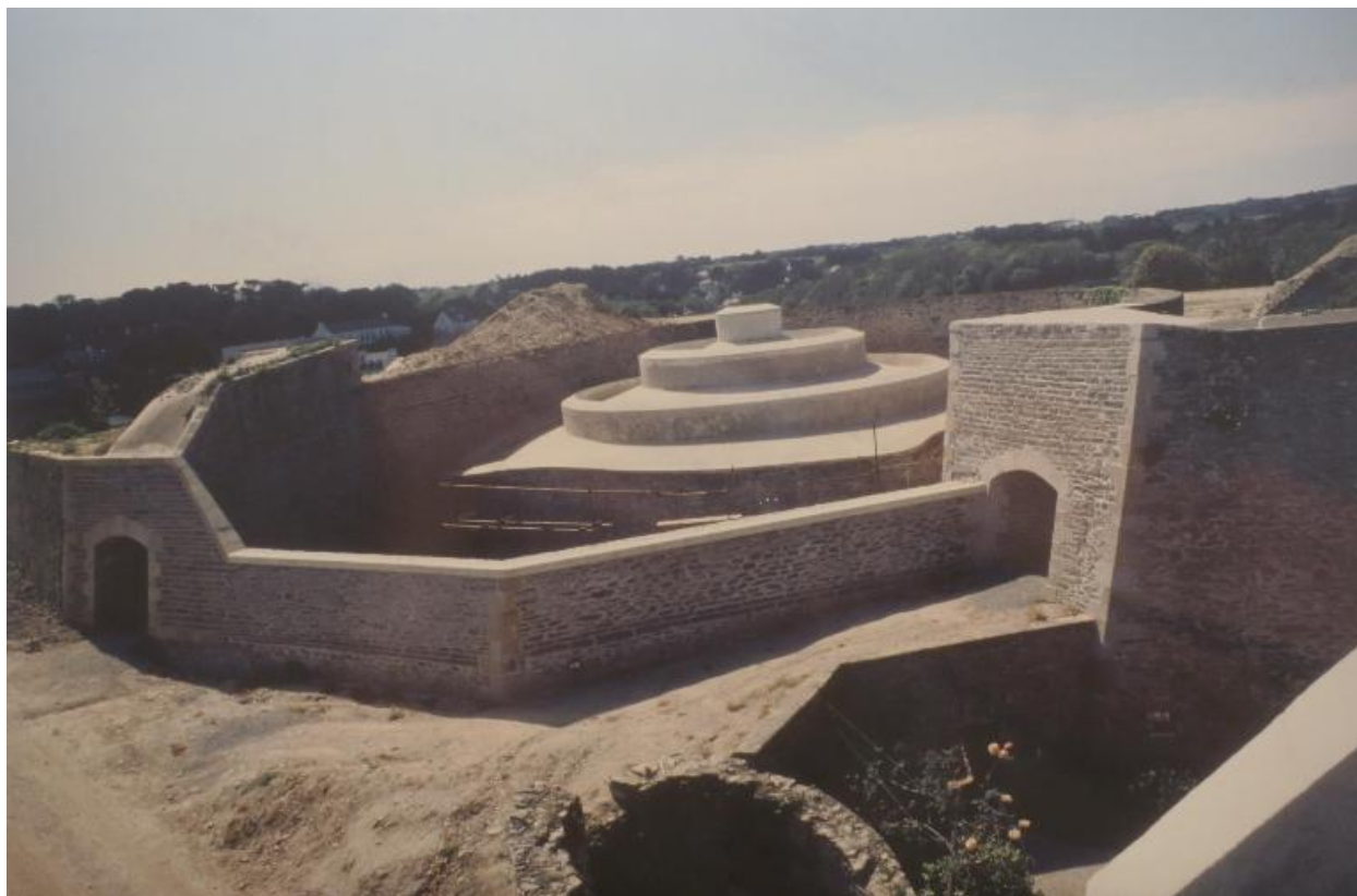
Le Palais, citadelle, cavalier du bastion 2, vue pendant la restauration.
