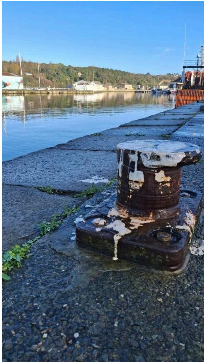
Bitte d'amarrage et traces d'usure
