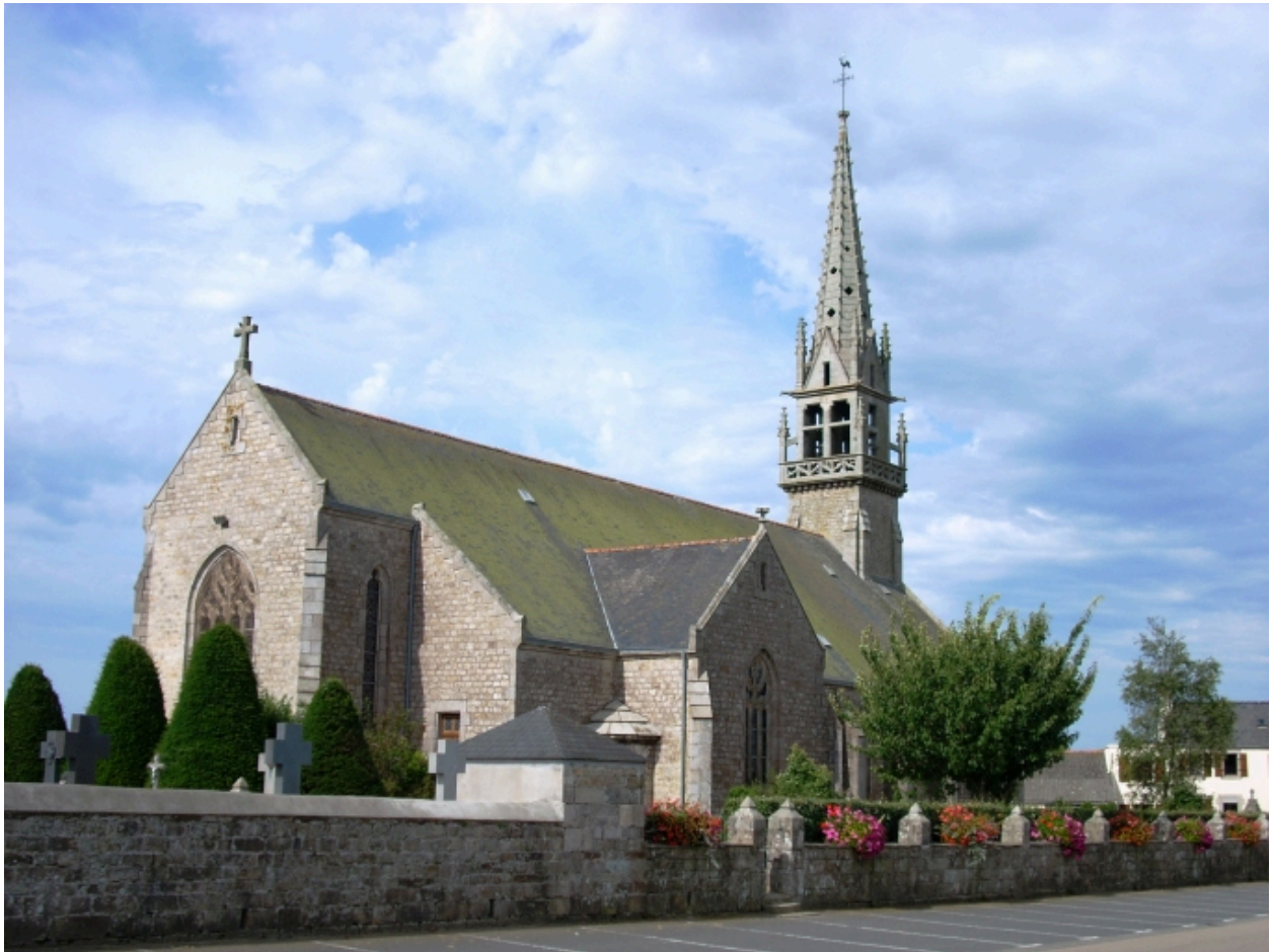
Vue générale nord-est
