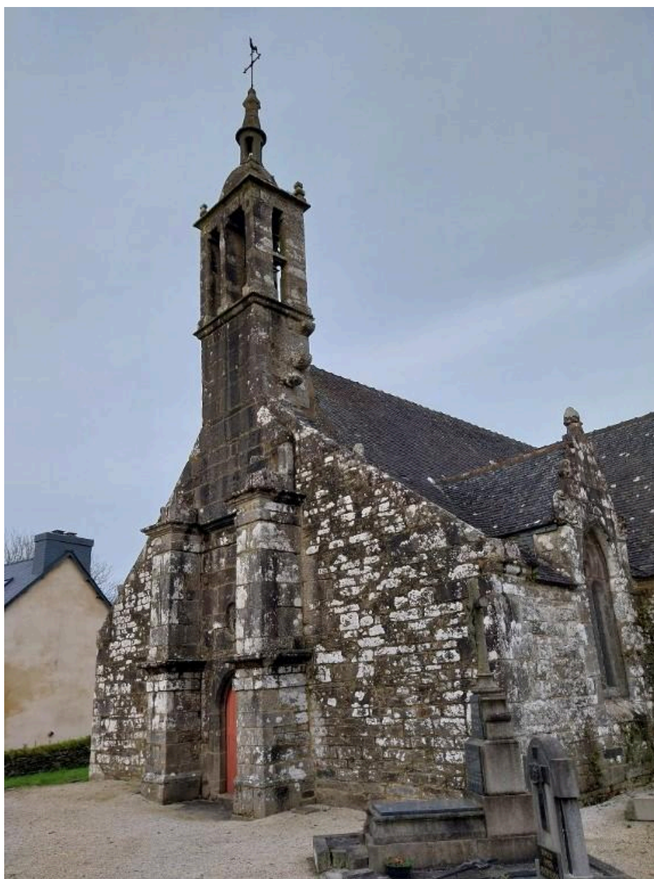
Vue du clocher depuis le sud-ouest
