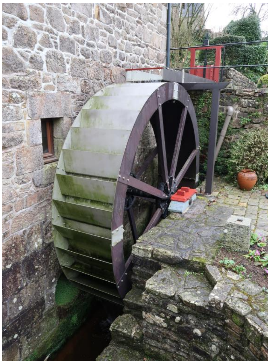
Loguivy-Plougras, le bourg : Moulin à eau de Traou an Dour, pignon nord, détail de la roue à aubes
