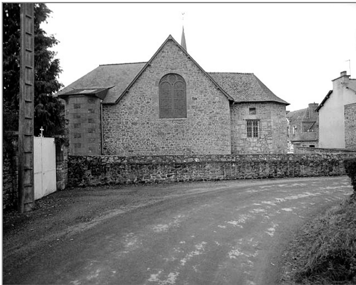
Elévation Est : vue générale
