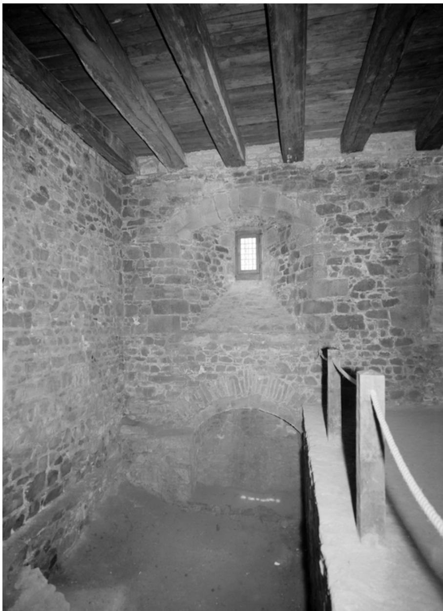
Vue du cellier : mur gouttereau antérieur (état en 1974). Doté de deux niveaux, le cellier est éclairé par deux petites baies et desservi par un soupirail
