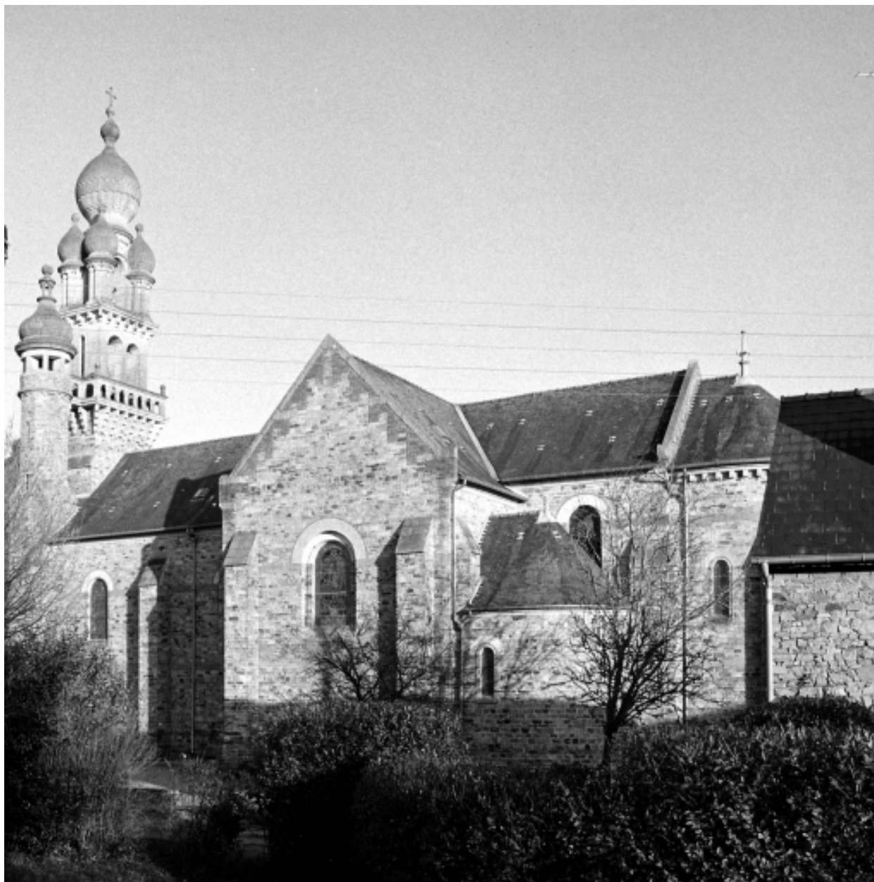
Elévation Ouest : vue générale
