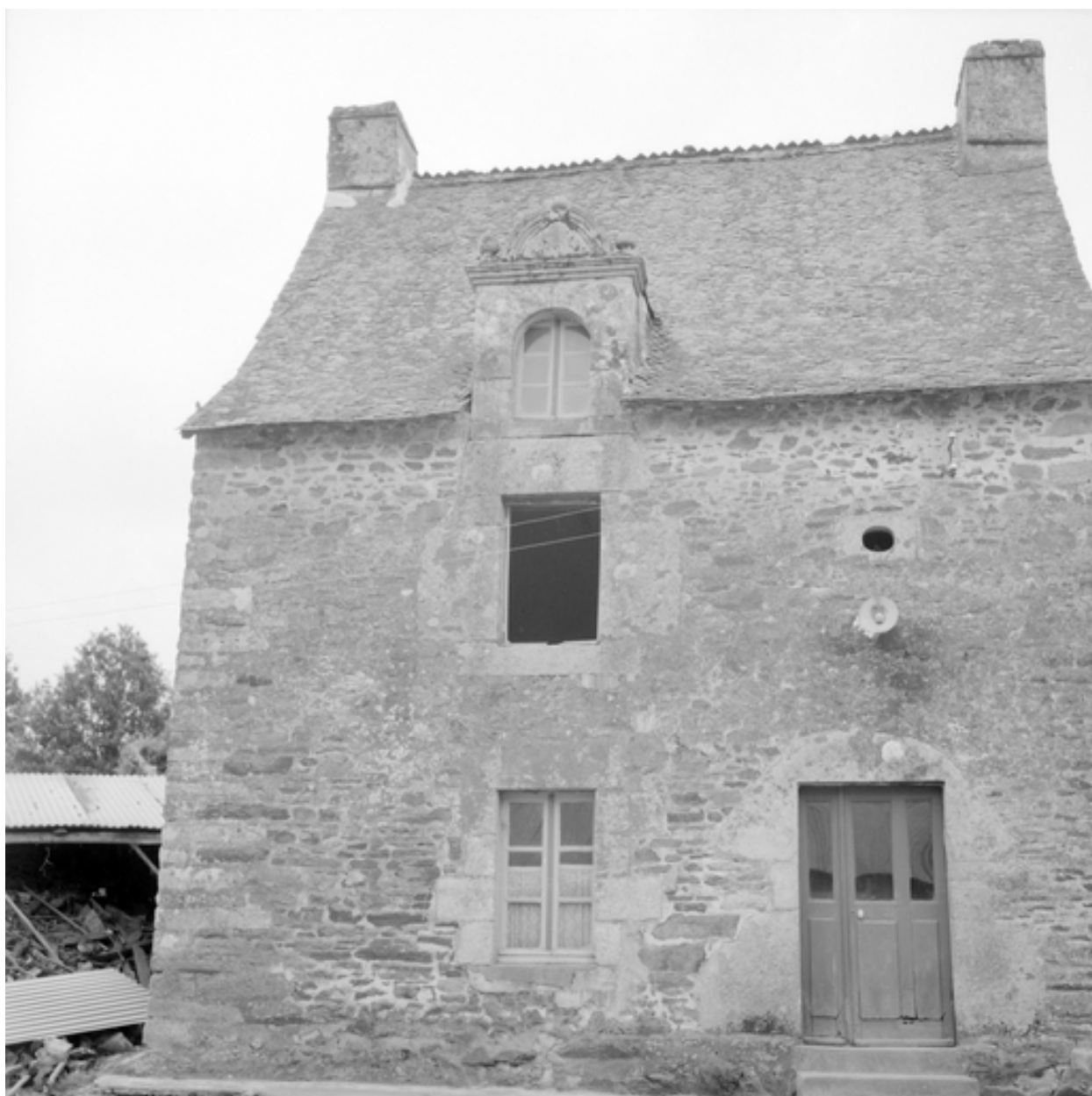
Vue d'ensemble de la façade sud
