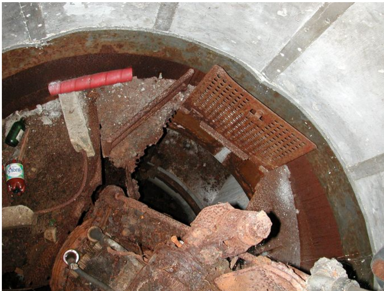
Vue intérieure : palier de la cloche blindée (état en 2003)
