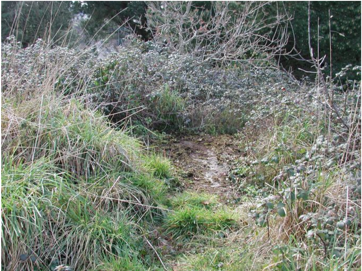
Vue de situation : dalle de couverture (état en 2002)
