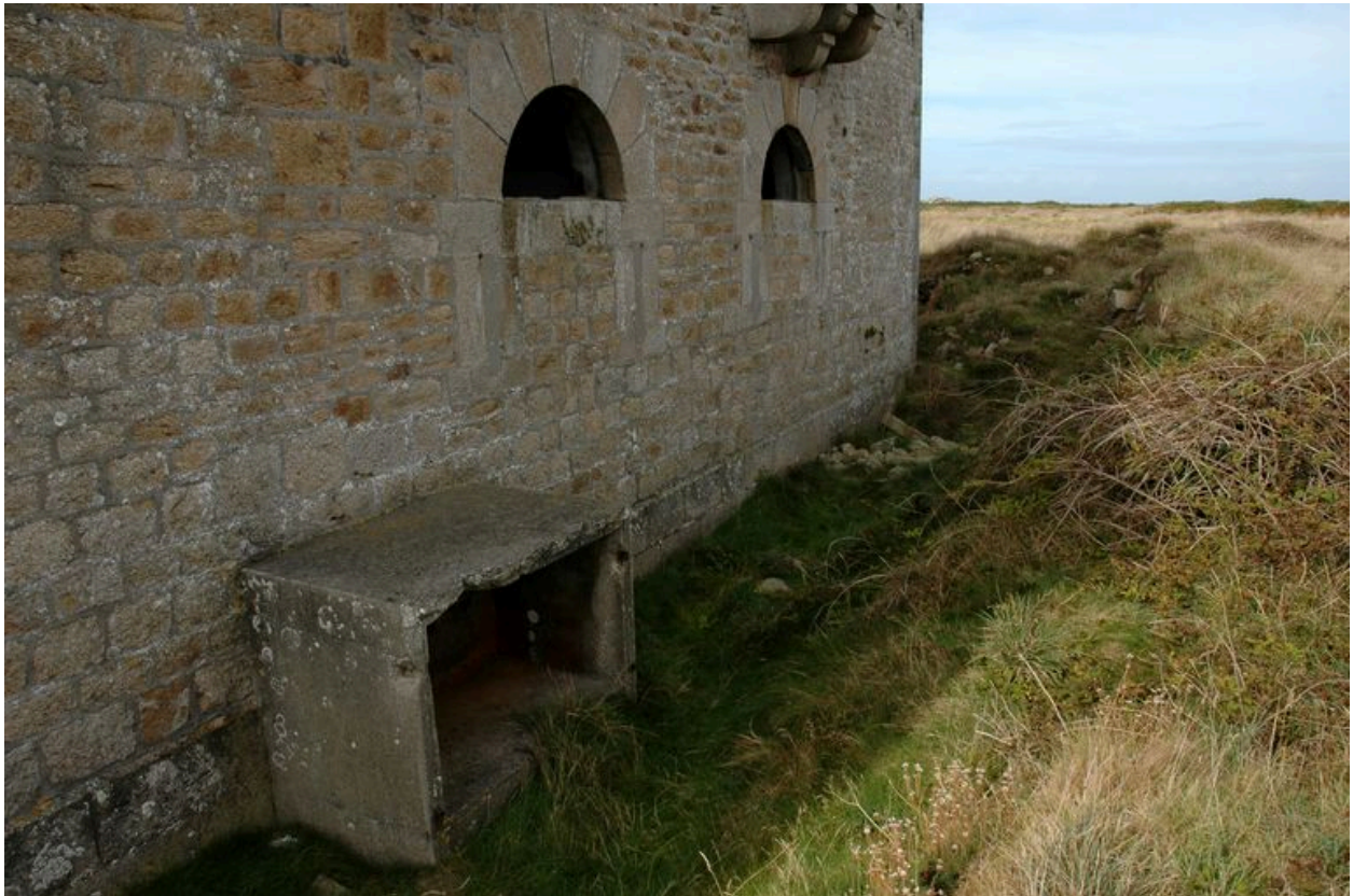
Vue du réduit de batterie de côte de Loqueltas, façade orientale. Niche à munitions d'origine allemande
