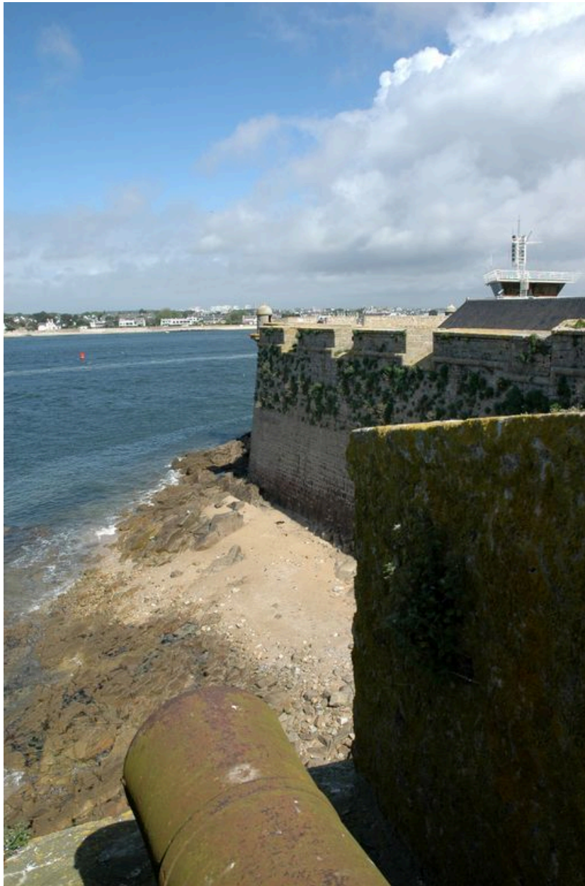
Vue de la citadelle de Port-Louis : embrasures plongeantes du bastion dit l'Irrégulier depuis le bastion des Chambres
