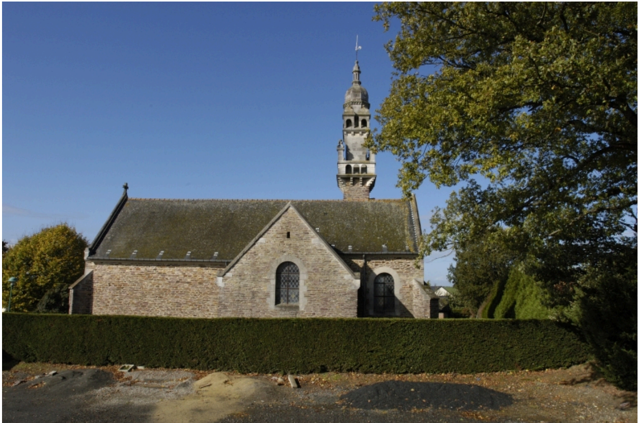
Façade est de l'église
