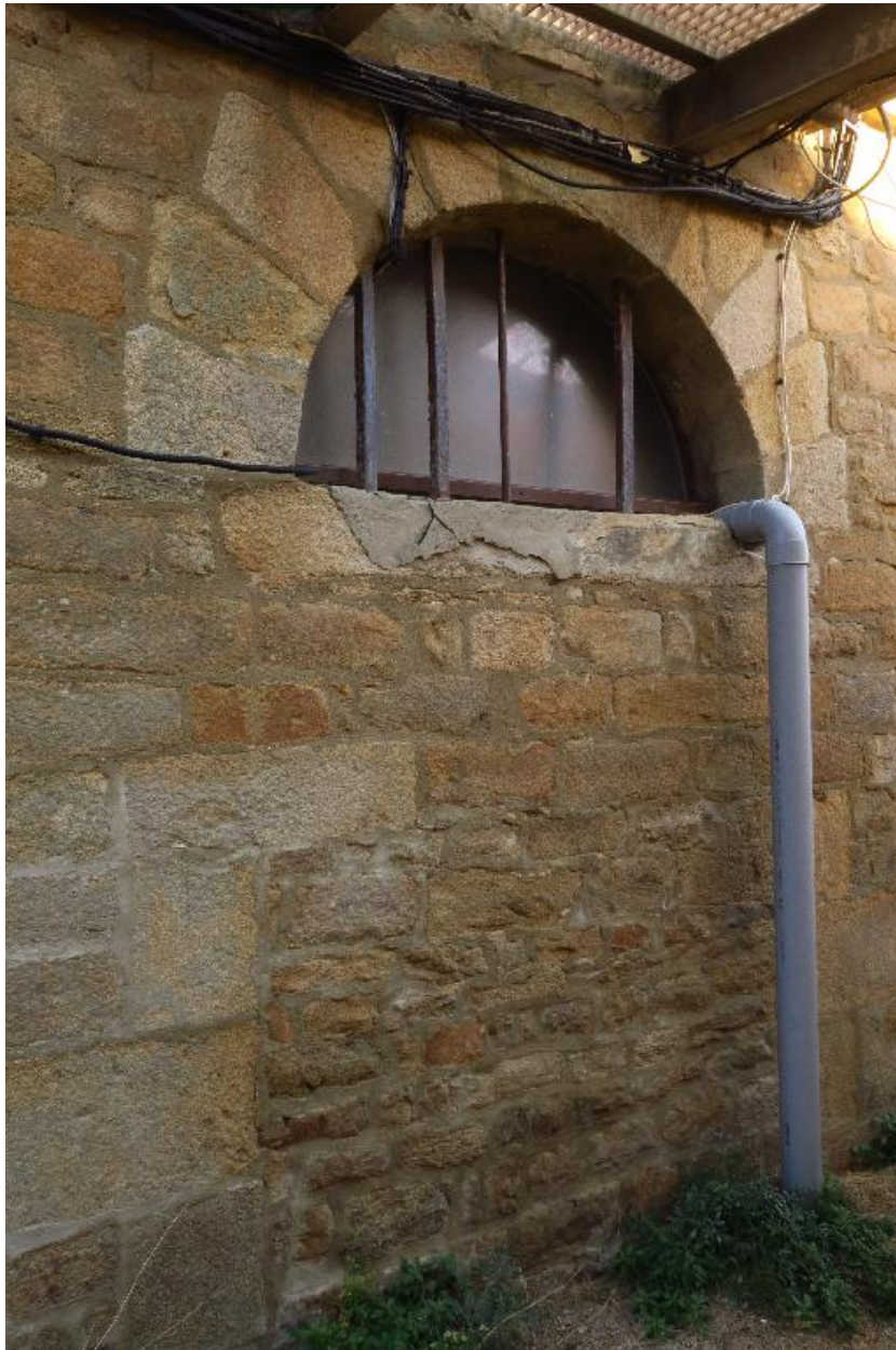
Saint-Pierre-Quiberon, fort de Penthievre, caserne défensive, baie et porte murée sur la face du demi-bastion nord-est.
