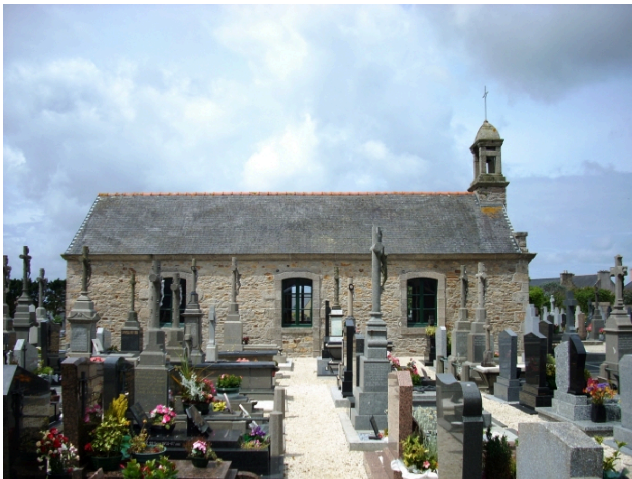
Plouguerneau, chapelle du cimetière : élévation nord
