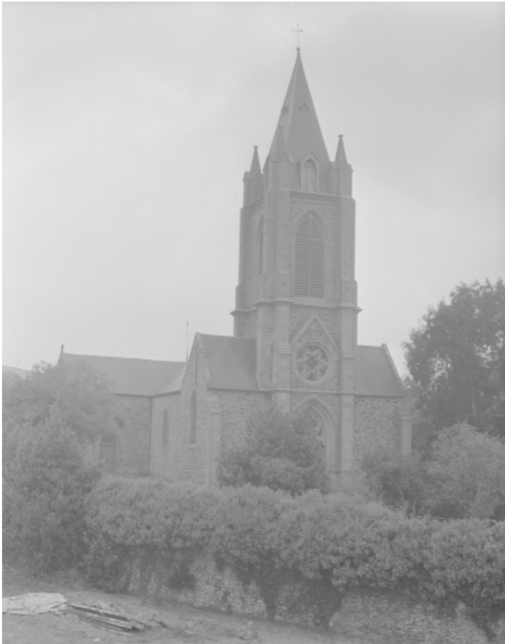
Elévation Ouest : vue générale
