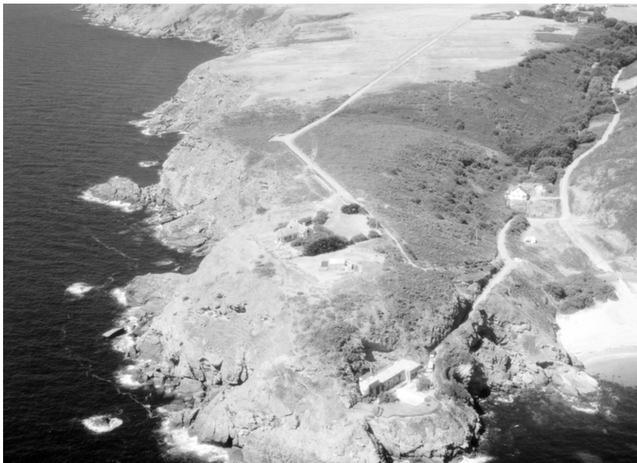
Locmaria, batteries de la pointe d'Arzic, vue aérienne prise de l'est.
